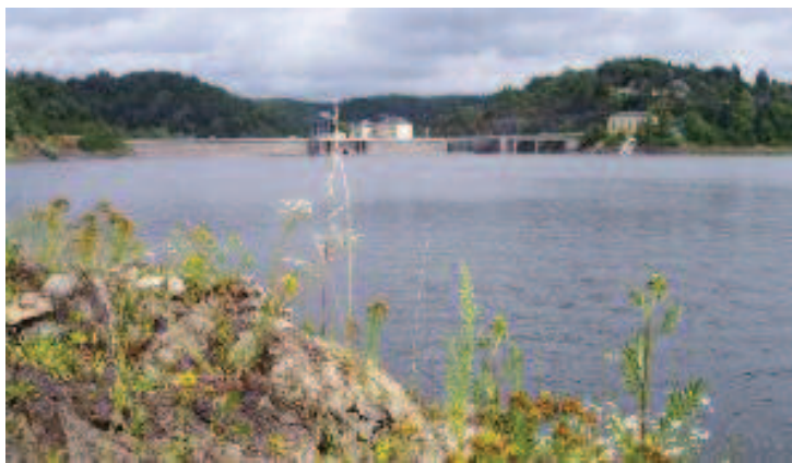
Mit ihren 215 Millionen Kubimetern Stauinhalt ist die Bleilochtalsperre, die im oberen Saalelauf zusammen mit anderen Talsperren betrieben wird, die größte Talsperre in Deutschland. Foto: A. Rudolph
